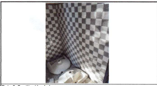
Foto 5: Sustitución de lavamanos
