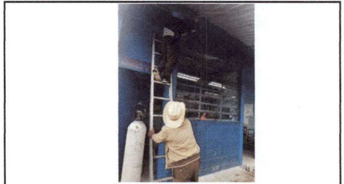
Foto 2: Sustitución de balcones de metal
