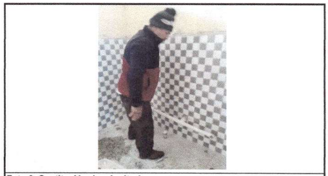
Foto 6: Sustitución de mingitorio
