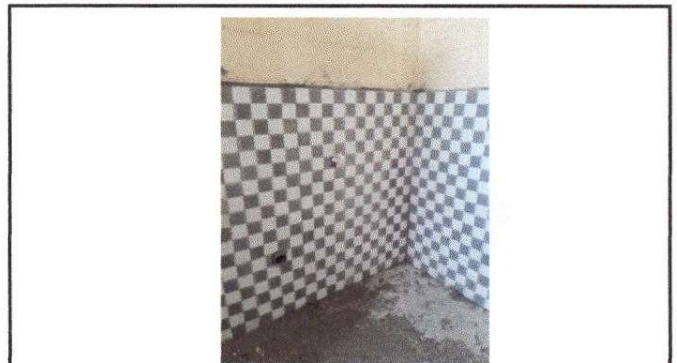
Foto 4: Sustitución de azulejo
